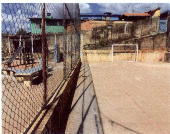
Foto 5 : Parte superior da obra com quadra poliesportiva.
