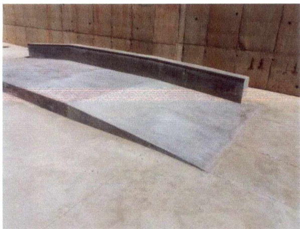
Foto 4 : Parte inferior da obra com pista para skate.
