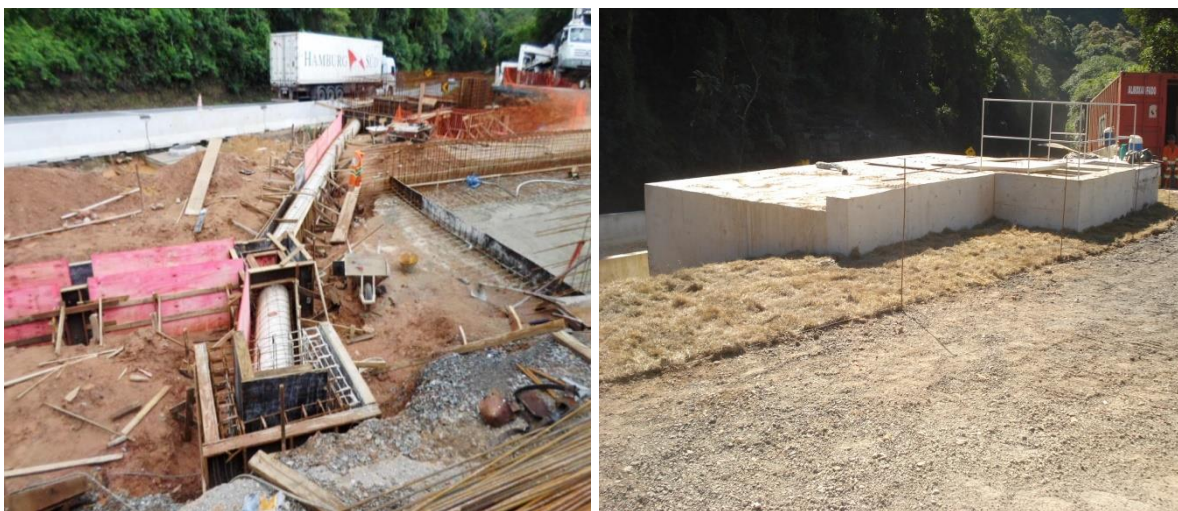
Figura 18: Execução das caixas de contenção de líquidos perigosos.
