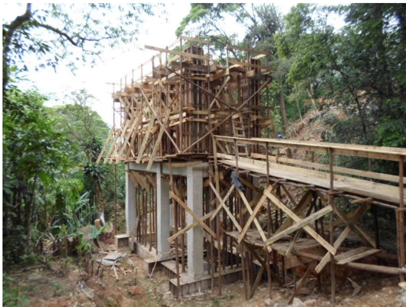
Figura 17: Execução da Mesoestrutura
