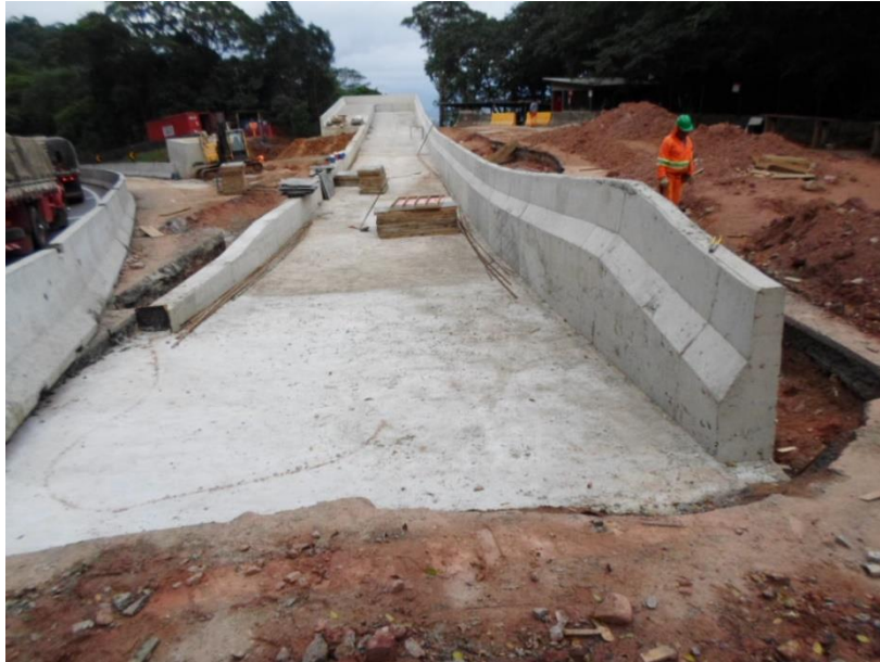
Figura 19: Execução da caixa de agregados (argila expandida)
