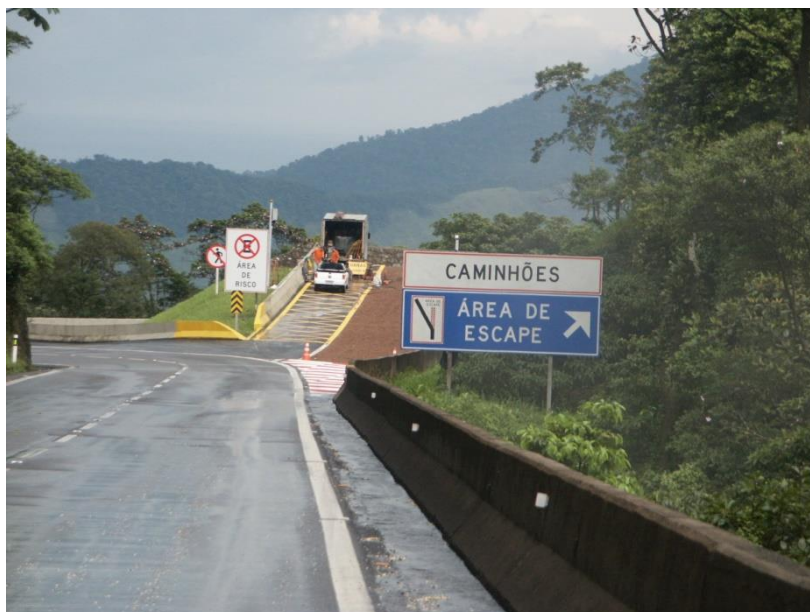
Figura 03 - Área de escape Km 42+700 Pista Sul SP-150
