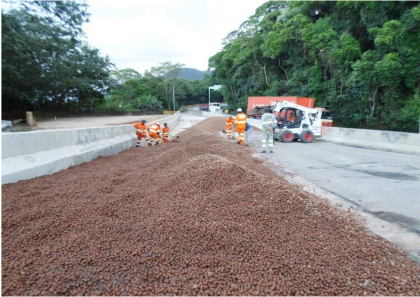
Figura 21: Preenchimento da caixa com argila expandida
