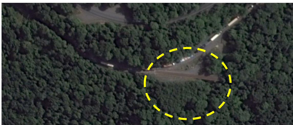
Figura 04: Foto aérea da área de escape Km 49+200 Pista Sul SP-150
