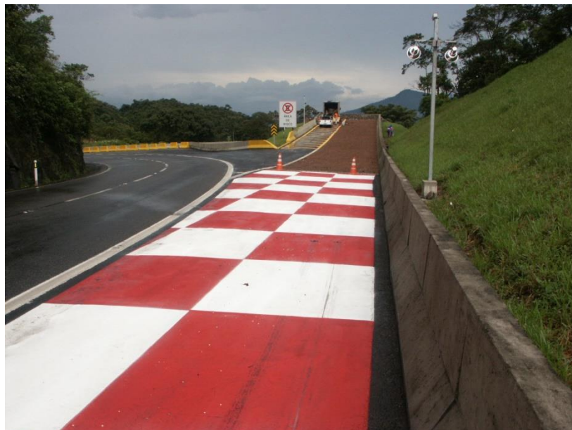
Figura 02: Visualização da entrada da Área de escape Km 42+700 Pista Sul SP-150
