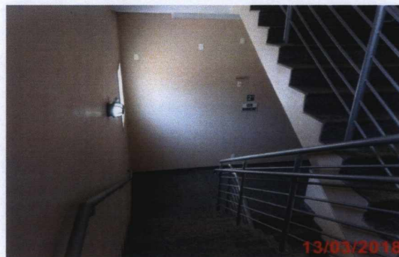
Escada de acesso ao 2º pavimento.
