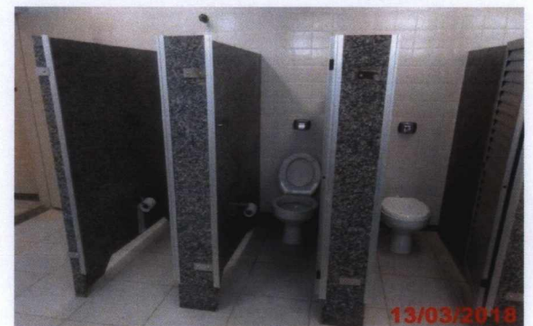
Vestiário masculino dos funcionários.
