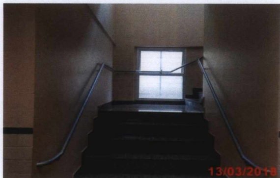
Escada de acesso à administração do C.S.
