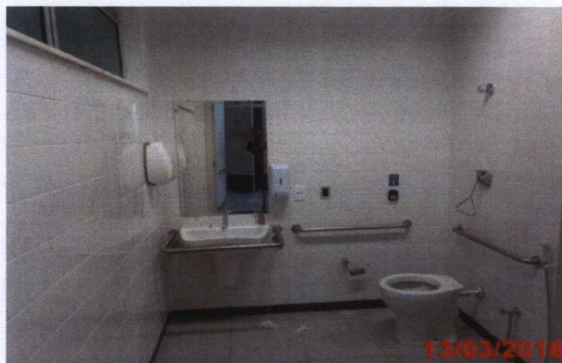
Creab – Vestiário masculino acessível.
