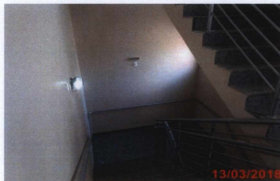
Escada de acesso ao 1º pavimento.
