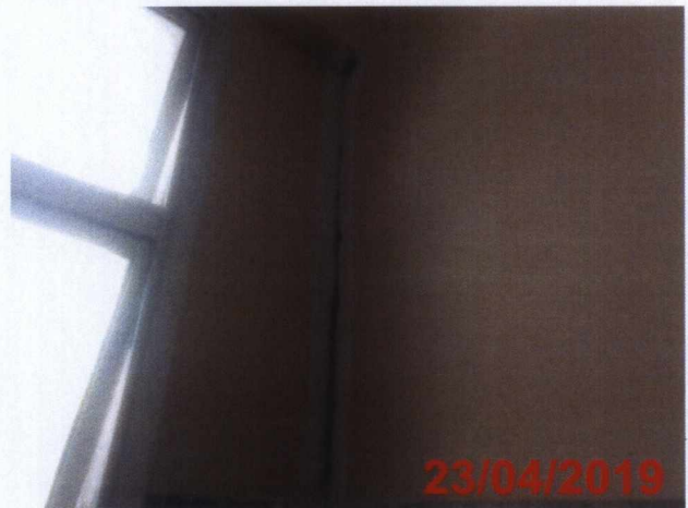
Tratamento de trinca na parede do Consultório 03 – Centro de Saúde 1º Pavimento.
