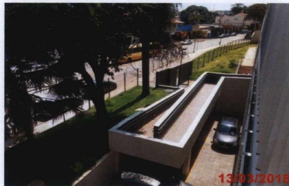
Rampa de acesso ao Complexo.
