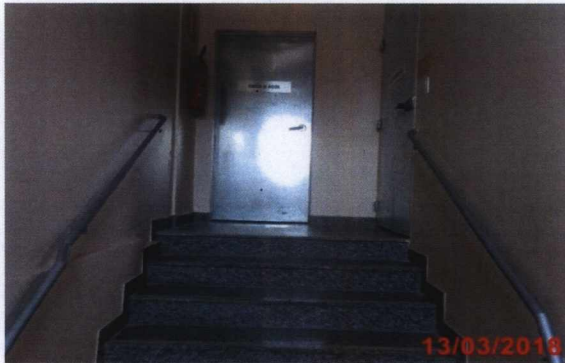
Escada acesso à cobertura.
