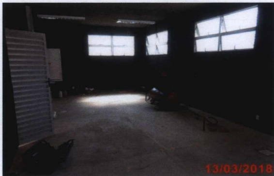
CEO – Casa de máquinas.
