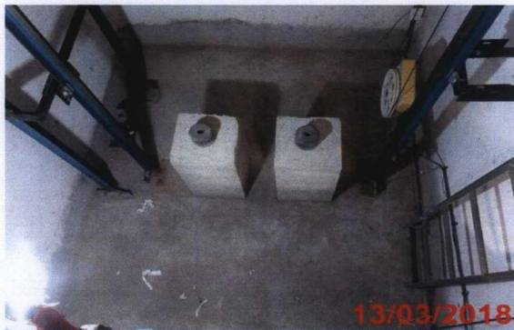
Fosso do elevador.
