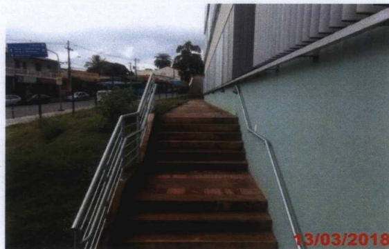
Escada de acesso à área externa do Bloco 01.
