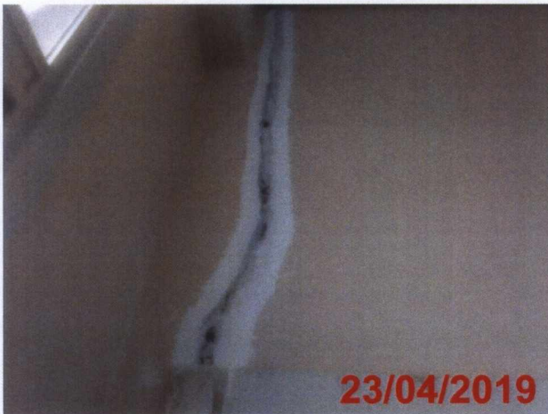
Tratamento de trinca na parede do Consultório 02 – Centro de Saúde 1º Pavimento.
