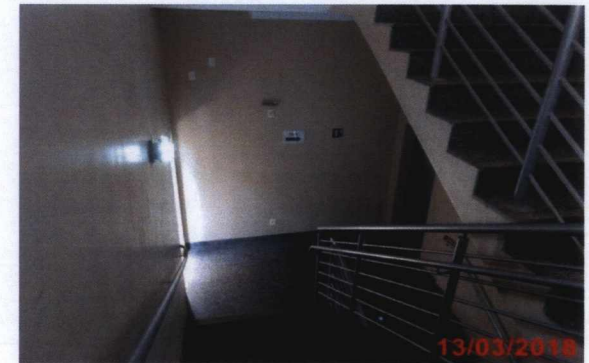
Escada de acesso ao 1º pavimento.
