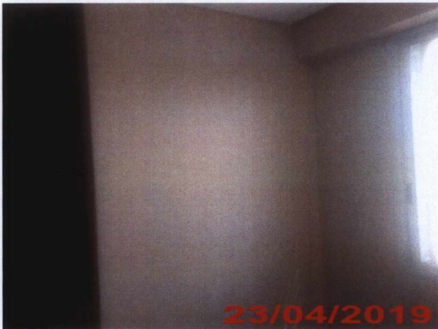
Pintura pós-tratamento de trinca na parede do Ginásio para AVD – 2º Pavimento CREAB.
