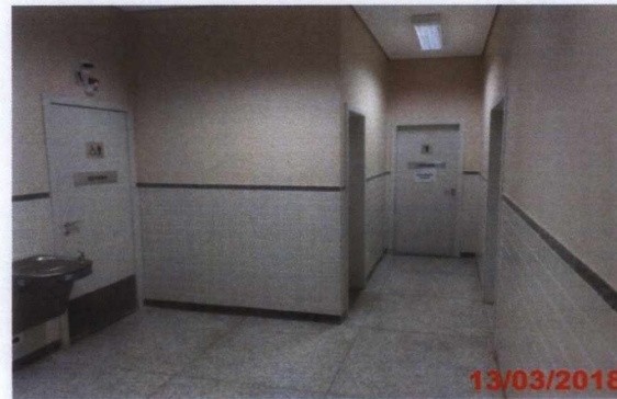
Hall dos vestiários.
