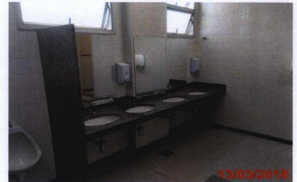
Vestiário masculino dos funcionários.
