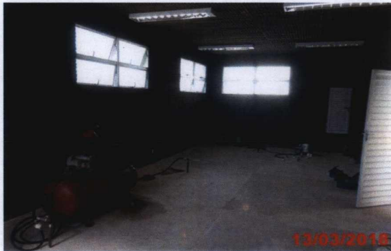
CEO – Casa de máquinas.
