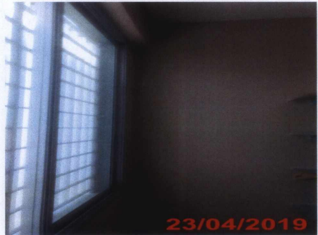
Pintura pós-tratamento de trinca na parede da sala de Gerência – 2º Pavimento CREAB.
