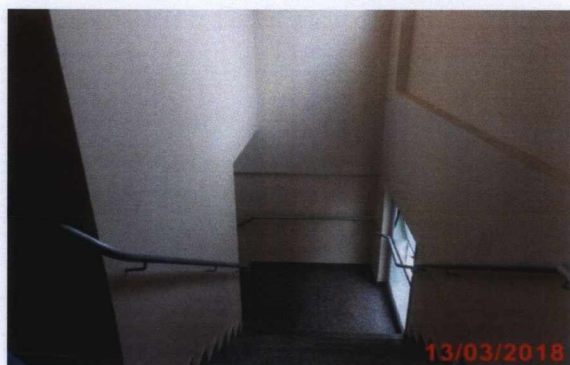
Escada de acesso à administração do C.S.
