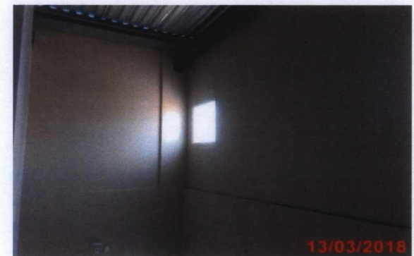
Fachada interna da cobertura.
