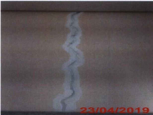
Tratamento de trinca na parede do banheiro da sala de espera – Centro de Saúde 1º Pavimento.
