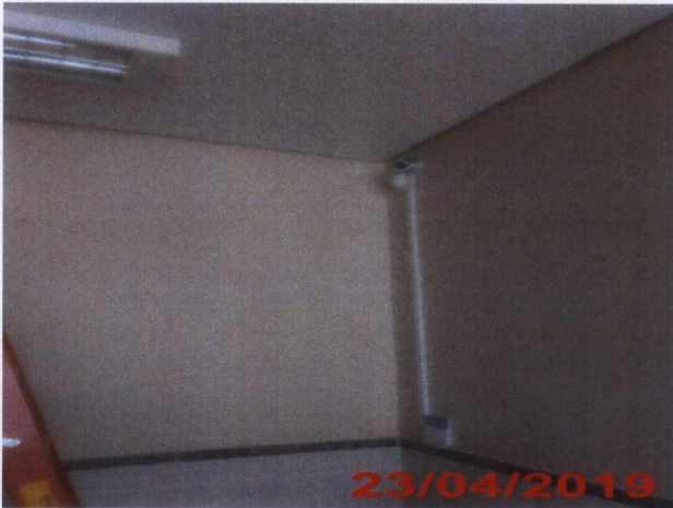
Pintura pós-tratamento de trinca na parede do Hall do CEM – 2º Pavimento.
