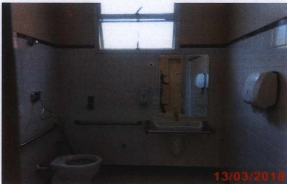
Vestiário acessível masculino dos funcionários.
