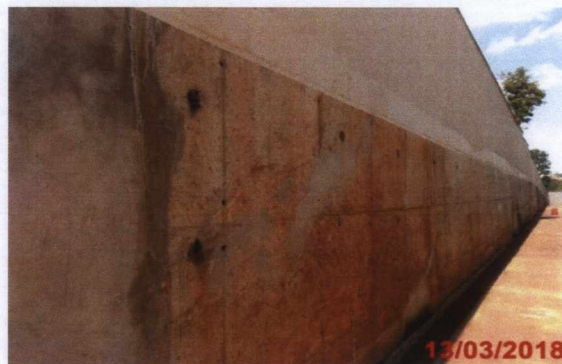
Muro de arrimo.
