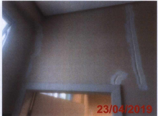
Tratamento de trinca na parede do banheiro do Consultório 06 – Centro de Saúde 1º Pavimento.
