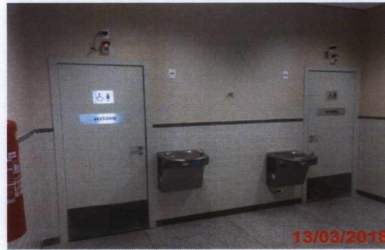
Hall dos vestiários.
