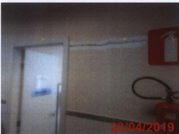
Tratamento de trinca na parede do corredor próximo ao Consultório 15 – Centro de Saúde 1º Pavimento.
