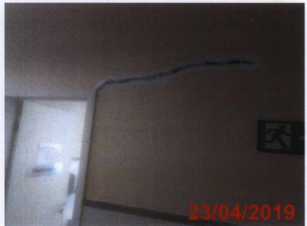
Tratamento de trinca na parede do corredor do Consultório 17 – Centro de Saúde 1º Pavimento.
