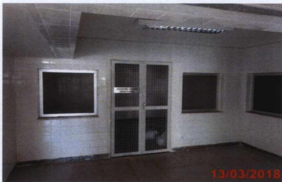
Subsolo – Hall Lavagem contêineres.
