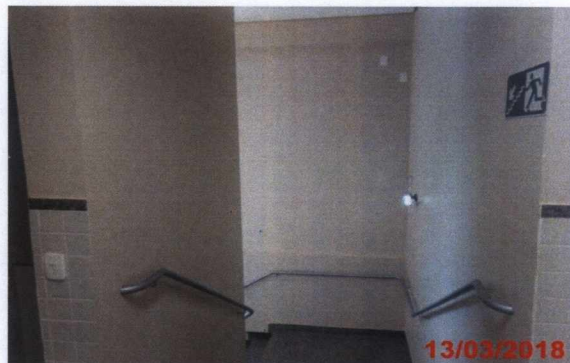
Escada de acesso à administração do C.S.
