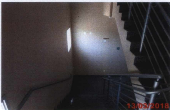
Escada de acesso ao 3º pavimento.
