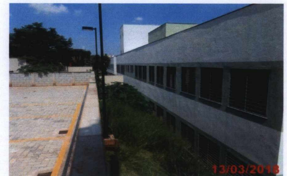
Fachada Posterior Bloco 01.
