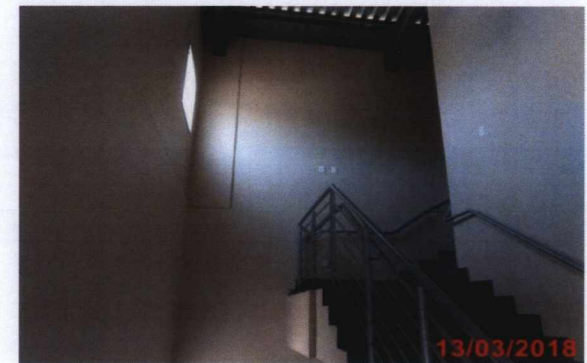
Fachada interna da cobertura.
