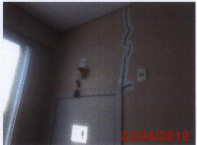
Tratamento de trinca na parede próximo aos banheiros da sala de espera – Centro de Saúde 1º Pavimento.
