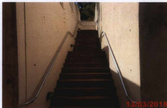
Escada de acesso ao estacionamento da Rua Ximango.
