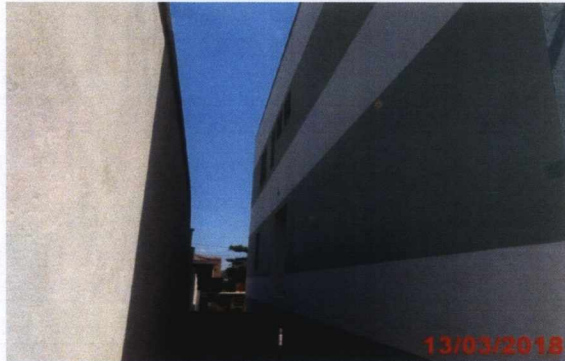
Fachada Lateral Bloco 02.
