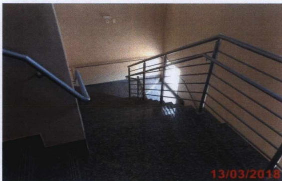
Escada de acesso ao 3º Pavimento.
