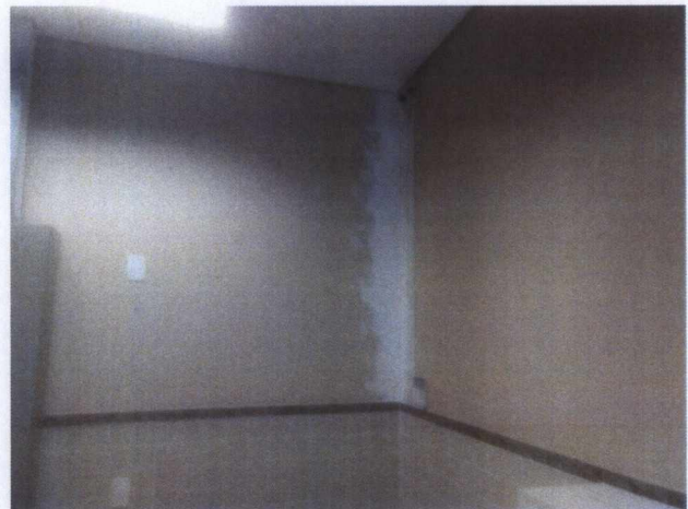
Tratamento de trinca na parede do Hall do CEM – 2º Pavimento.
