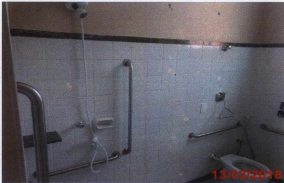
Vestiário acessível masculino dos funcionários.
