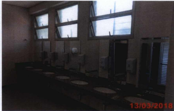
Vestiário Feminino dos funcionários.
