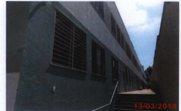
Fachada Posterior Bloco 02.
