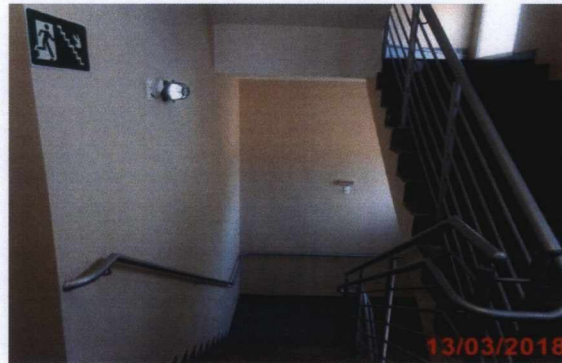
Escada de acesso ao 2º pavimento.
