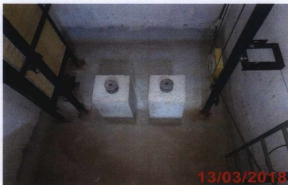
Fosso do elevador.
