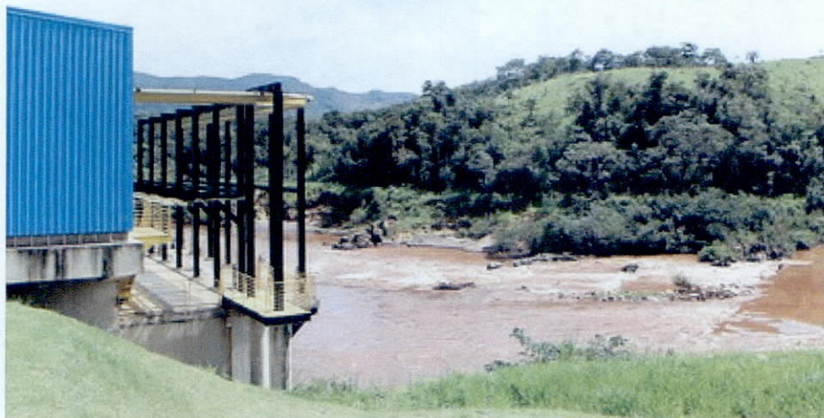
Captação da Copasa no Rio Paraopeba
