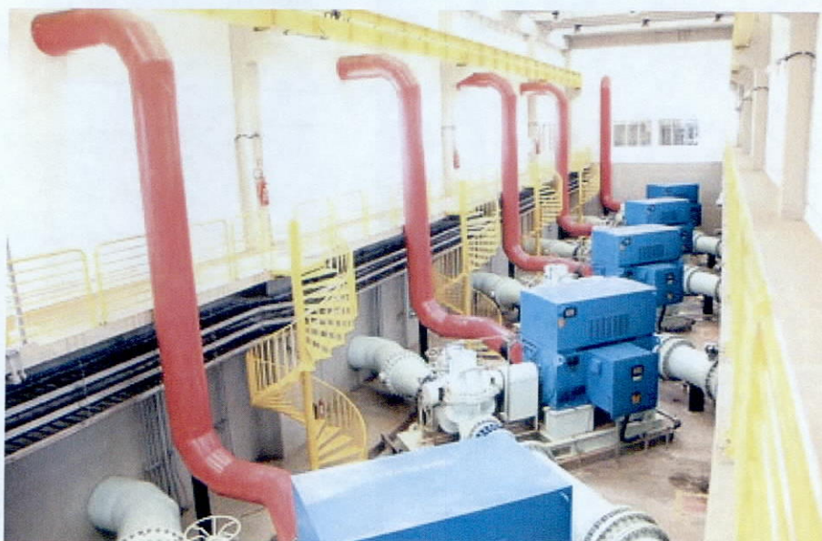
Estrutura da captação da Copasa no Rio Paraopeba
