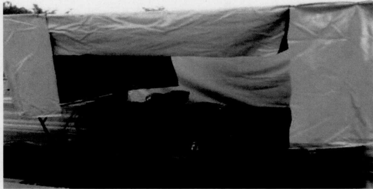
Figura 10 - Solda das estacas prancha.
