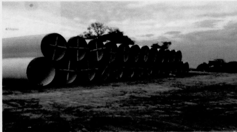
Figura 6 - Estoque da tubulação de aço carbono.
