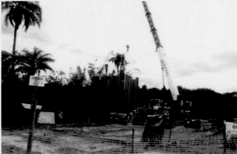
Figura 13 - Cravação das estacas prancha.
