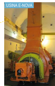
INÍCIO DA OPERAÇÃO: 1936 POTÊNCIA: 2744 KW | QUEDA BRUTA: 97 m
