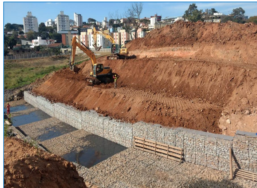
Execução de obras da bacia de retenção do córrego São Francisco / Assis das Chagas, regional Pampulha (Julho/19)
