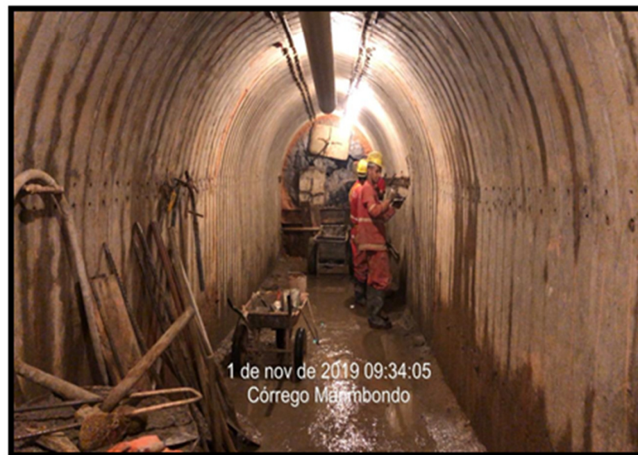
Obra de contenção de cheias e regulação da vazão do Córrego Marimbondo – construção subterrânea de minitúnel na rua José Maria Botelho – Bairro Santa Mônica (Novembro/19)
