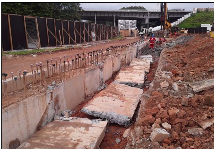
Demolição de mureta guia de parede diafragma.
