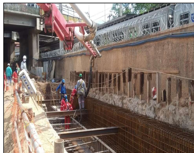
Concretagem da viga 03 da caixa de interligação.
