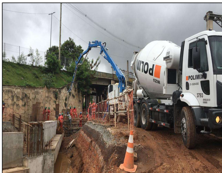
Concretagem da viga 03 da caixa de interligação.
