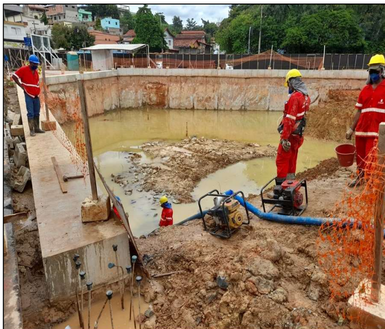
Execução de bombeamento de água de chuva da caixa de captação.
