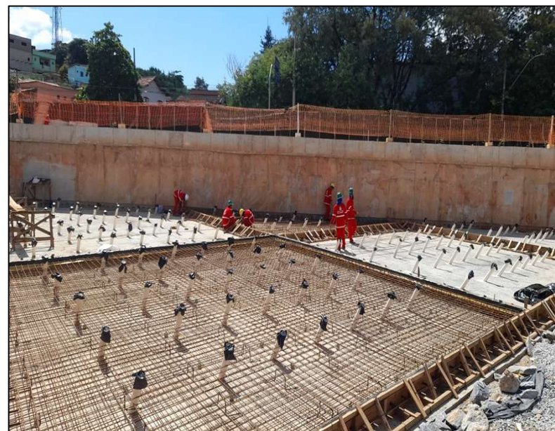
Armação de aço de laje de fundo da caixa de captação.
