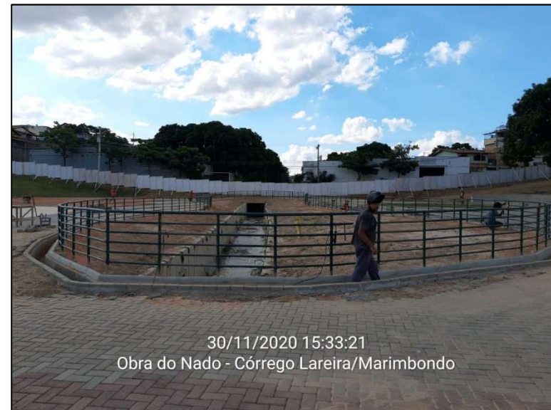
Obra de contenção de cheias e regulação da vazão do Córrego Marimbondo – Bairro Santa Mônica (Novembro/20)
