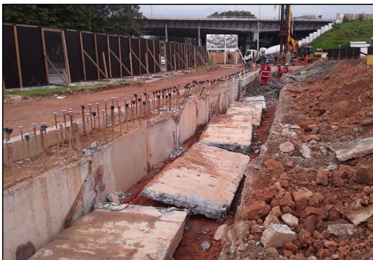
Demolição de mureta guia de parede diafragma.
