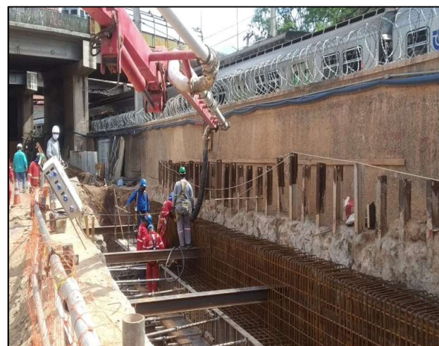
Concretagem da viga 03 da caixa de interligação.
