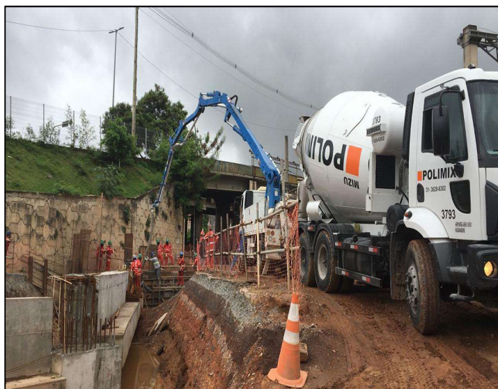
Concretagem da viga 03 da caixa de interligação.
