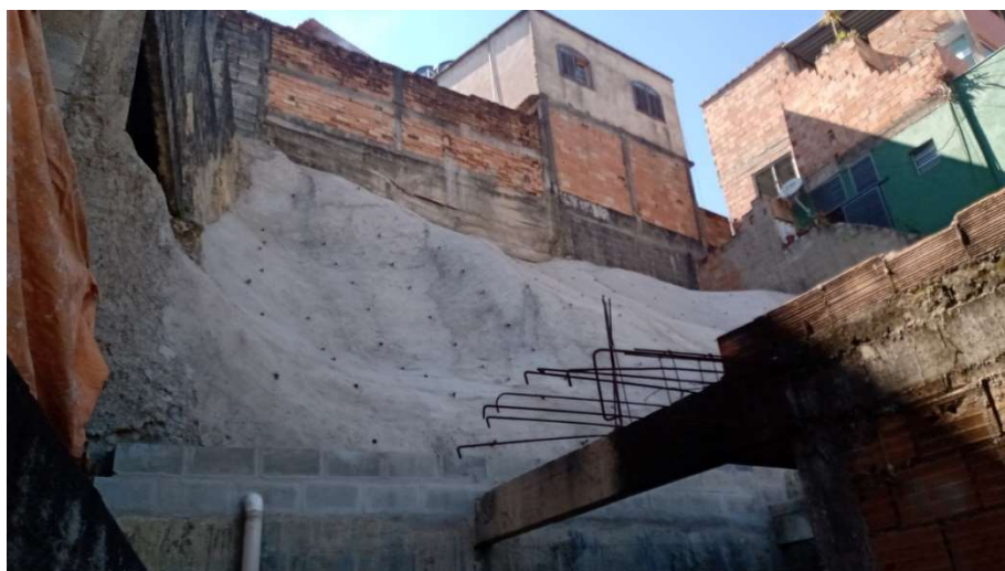
Execução de proteção da encosta e drenagem na Rua Flor da Ameixa, 350 – Jardim Alvorada – Pampulha
