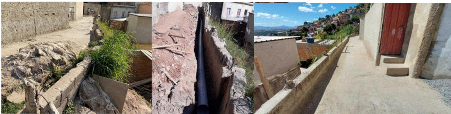
Execução de contenções, drenagem e recuperação de acessos – Beco Petrolina, Vila Nossa Senhora de Fatima – Centro Sul
