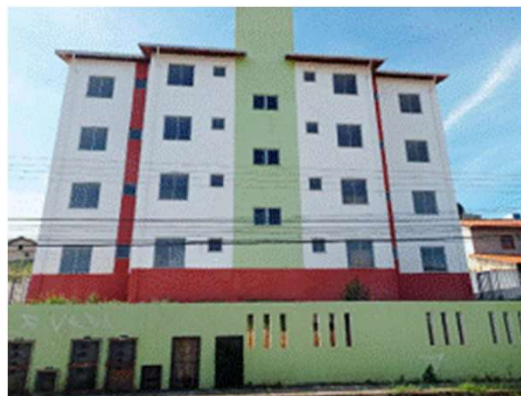
Resid. Mangueiras Regional Barreiro
