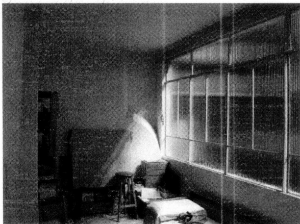
Uma varanda frontal, com fechamento em metalon e vidro. Notar a solução arredondada para compor a transição da varanda de um vizinho para o outro.
