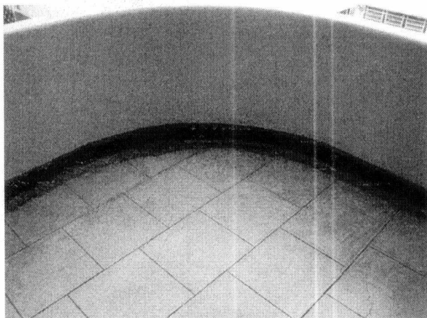
Detalhe do piso original, em placas de cimento polido, nas áreas de circulação entre escadas.
