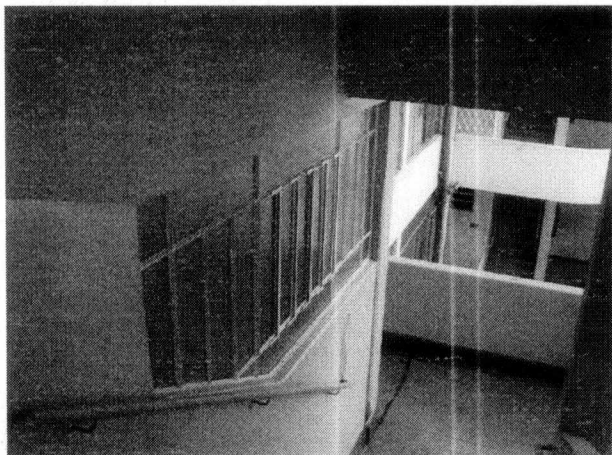
Vão de iluminação da área de serviço fechado em bascula horizontal.
