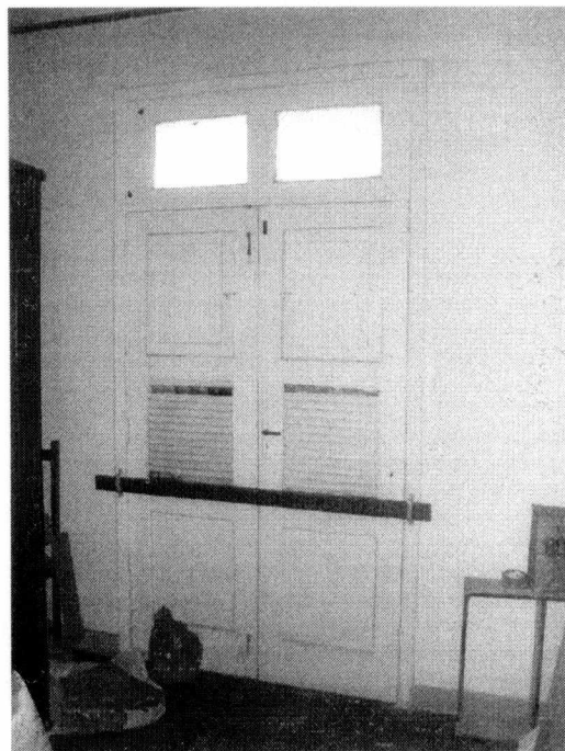
Neste detalhe, o mesmo padrão de porta, dupla, adaptado para a sala, vista interna. Rodapé original de marmorite.
