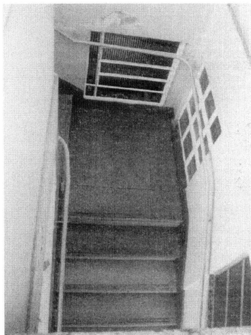
Detalhe da escada, onde se vêem as janelas fixas que servem de iluminação das cozinhas. A da direita é original, a da esquerda não.
