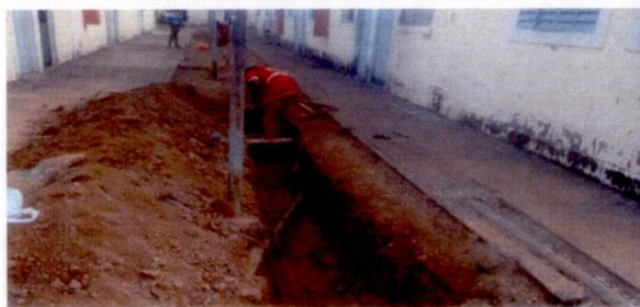
FOTO 2 – Início da escavação para implantação das canaletas para drenagem do pátio de todo o Abrigo – JULHO/2019
