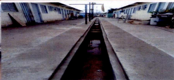
FOTO 3 – Concretagem das canaletas de drenagem de todo o pátio do Abrigo – AGOSTO/2019
