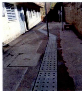
Foto 5 – Implantação de canaletas de drenagem ao longo de todo o pátio evitando poças d'água
