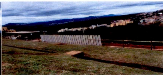
FOTO 7 – Início de construção de muro tipo calha V que foi instalado nos fundos do Abrigo – NOVEMBRO/2019
