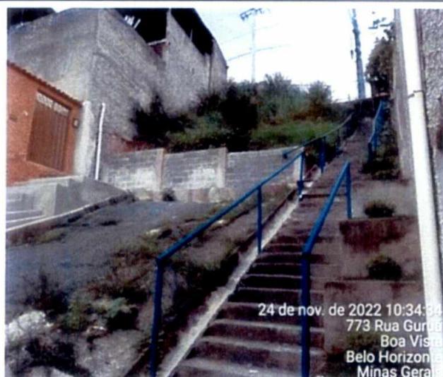
Figura 08 – Após intervenção – Manutenção e pintura do corrimão . (Fonte: autor, 24-11-2022).
