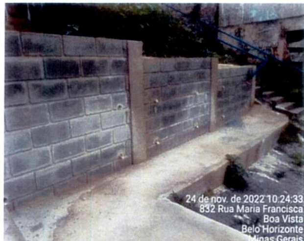
Figura 06 – Após intervenção – Execução do muro de contenção e passeio, assentamento de canaleta para escoamento da água pluvial. (Fonte: autor, 24-11-2022).
