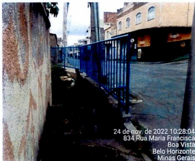
Figura 04 – Após intervenção – Execução de passeio, alteamento meio-fio, instalação e pintura do guarda-corpo/corrimão. (Fonte: autor, 24-11-2022).
