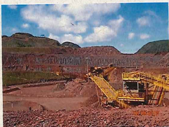
Foto 03. Vista dos taludes próximos à UTM, apontando a presença de ravinamentos.
