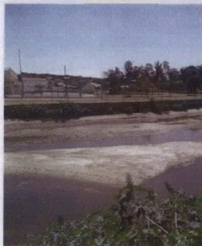
Figura 03: Córrego Ressaca/Sarandi já assoreado e com sedimentos
