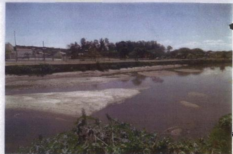
Figura 03: Córrego Ressaca/Sarandi já assoreado em 26/02/2014, apenas 13 dias após as ações de desassoreamento.
