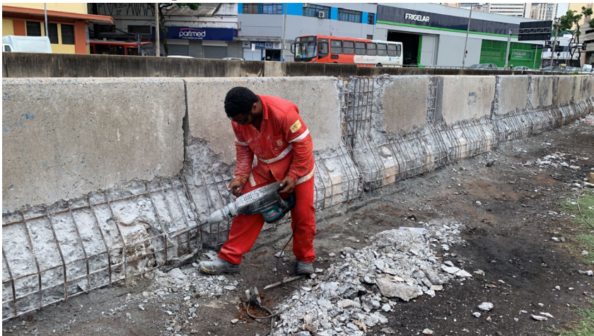
Recuperação de new jersey, Rib. Arrudas, trecho R.Mato Grosso até R. 21 de Abril, abr/23
