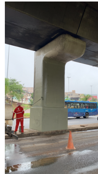
Limpeza e pintura dos pilares do viaduto Nansen Araújo, abr/23
