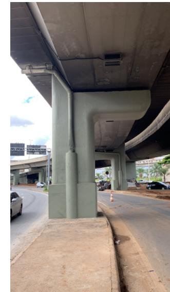
Limpeza e pintura dos pilares do viaduto Nansen Araújo, abr/23
