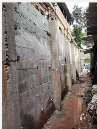
Obra de Contenção e Drenagem R. Cidade Nova, 17 Vila São Jorge III - Oeste
