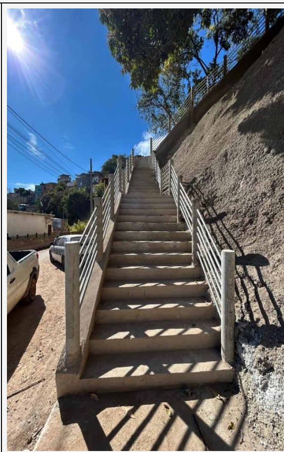
Escada de acesso entre o beco e a rua finalizada.
