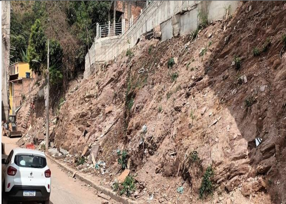
Vista a direita do talude antes de finalizar a obra.
