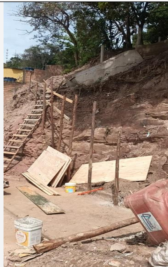
Antes de executar a escada de acesso entre o beco e a rua.
