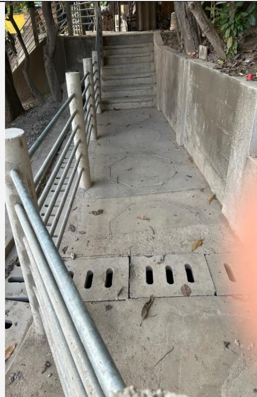
Urbanização finalizada do beco.
