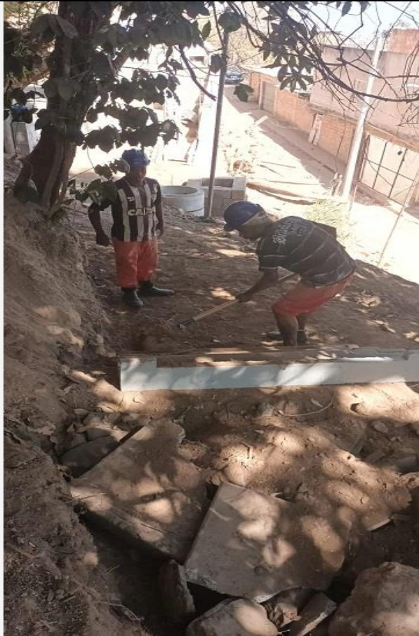
Antes de executar a canaleta.
