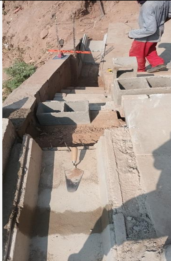
Execução da canaleta.
