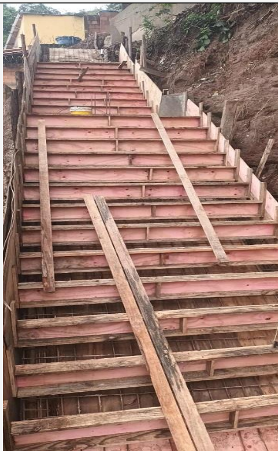
Durante a execução da escada de acesso entre o beco e a rua.
