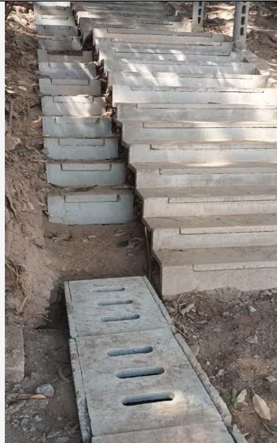
Durante a execução da escada de acesso as residências.
