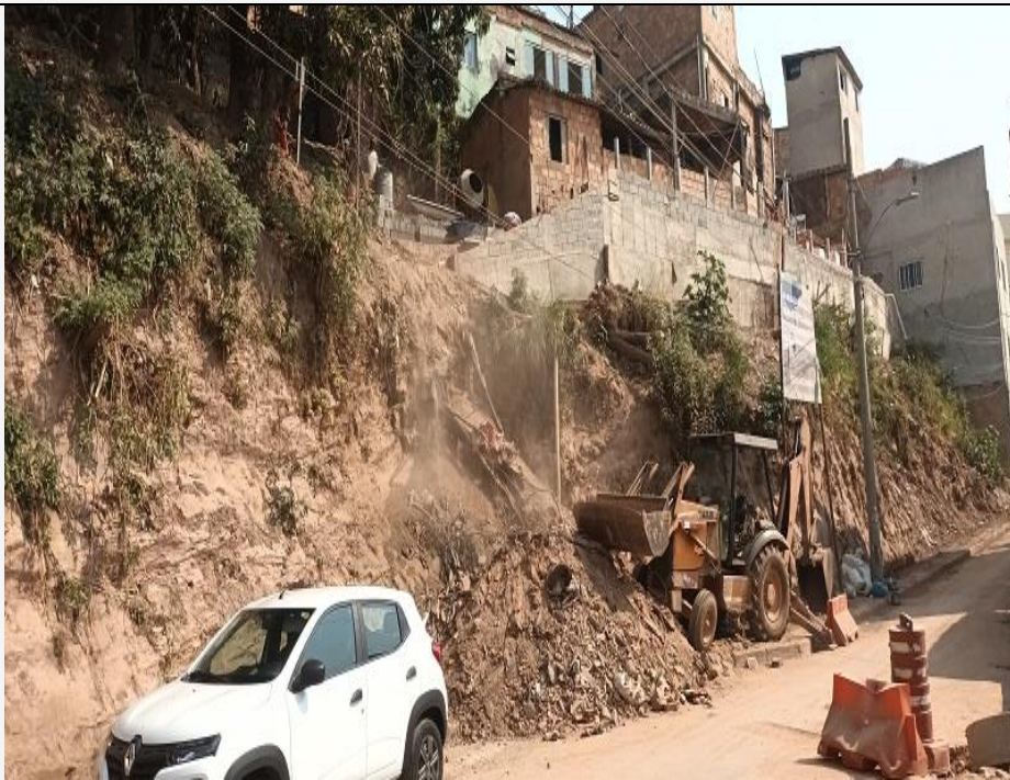
Vista a direita do talude antes de finalizar a obra.
