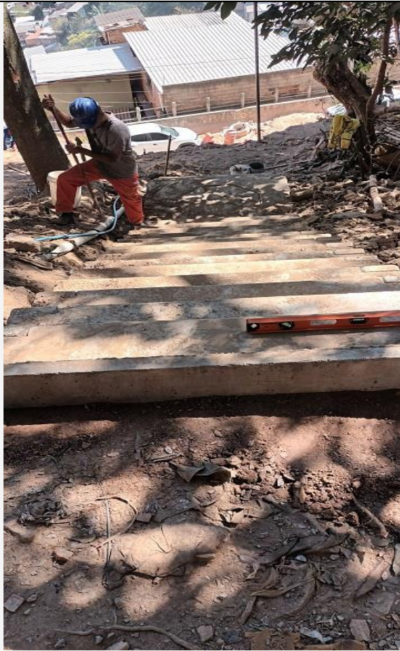
Antes de executar a escada de acesso as residências.
