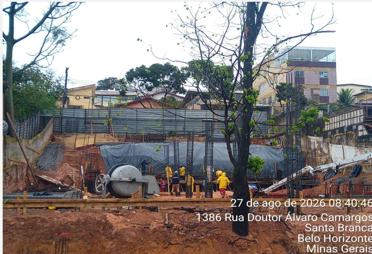
Obras iniciadas no CERSAM Venda Nova
