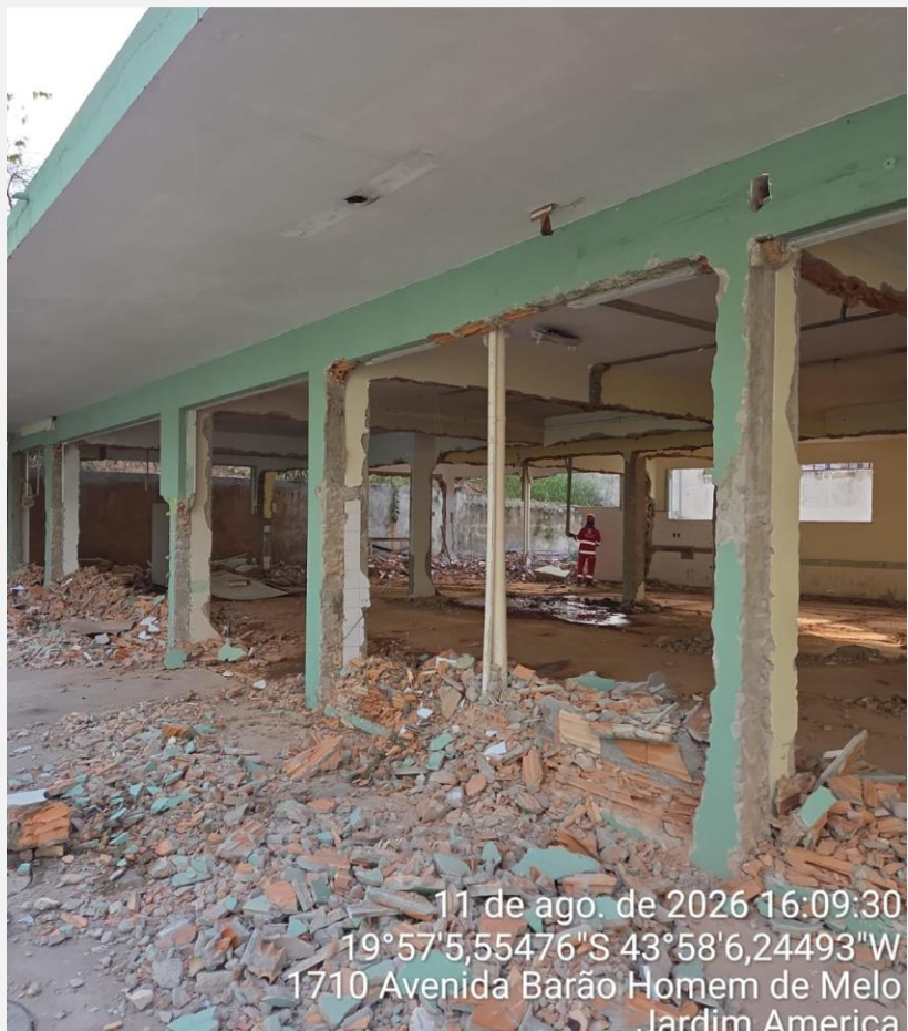
Reforma e Ampliação da UPA Oeste
