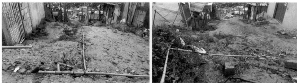
Imagens dos canos e válvulas da rede autoconstruída de distribuição de água ao longo das vias
