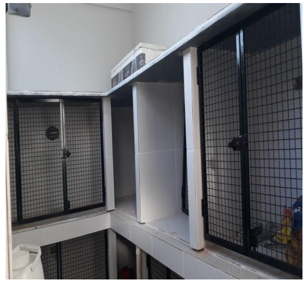
Foto 18 - HOSPITAL PÚBLICO VETERINÁRIO SALA DE INTERNAÇÃO CÃES- DEPOIS
