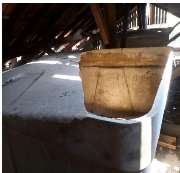
Foto 26 - HOSPITAL PÚBLICO VETERINÁRIO CAIXA D'ÁGUA - ANTES
