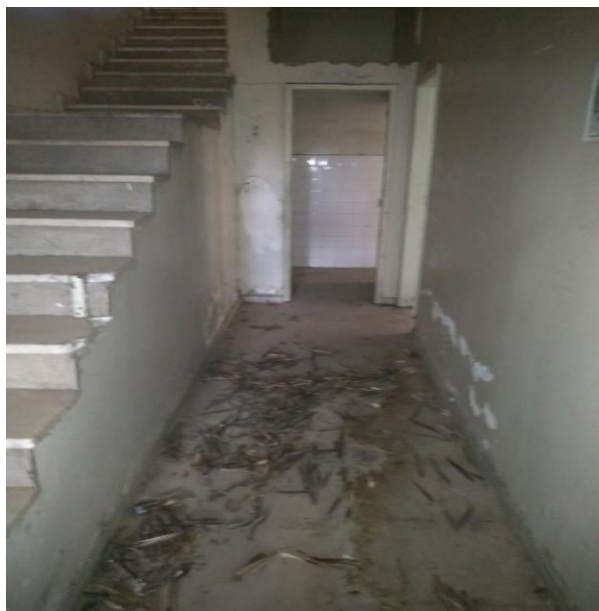
Foto 7 - HOSPITAL PÚBLICO VETERINÁRIO SUBSOLO- ANTES
