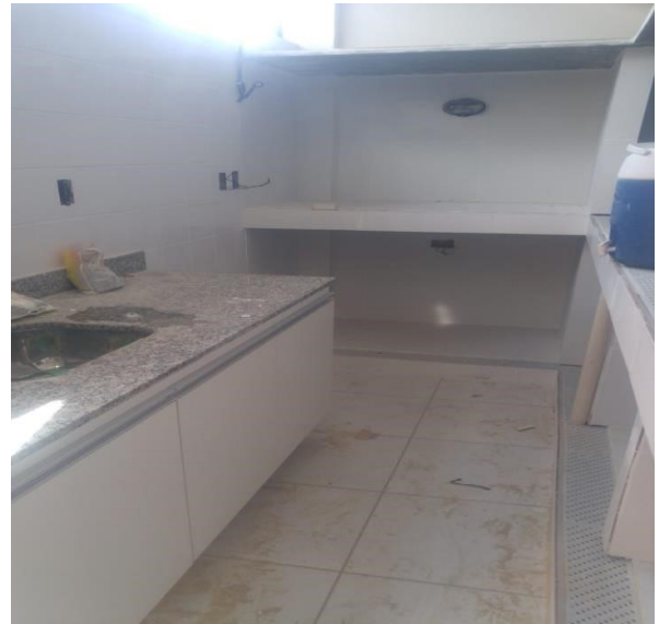
Foto 10 - HOSPITAL PÚBLICO VETERINÁRIO SALA DE INTERNAÇÃO CÃES - DEPOIS
