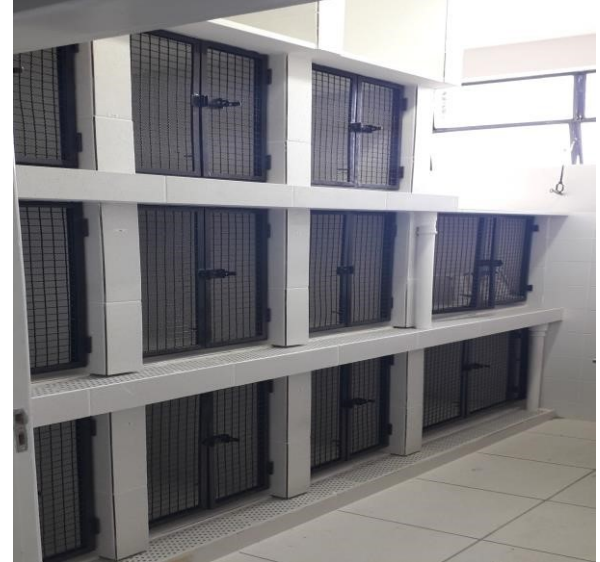
Foto 26 - HOSPITAL PÚBLICO VETERINÁRIO SALA DE INTERNAÇÃO GATOS- DEPOIS
