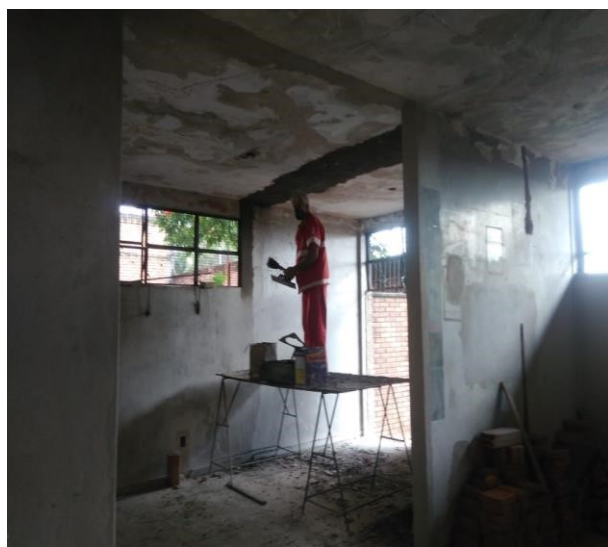
Foto 11 - HOSPITAL PÚBLICO VETERINÁRIO HALL DE ENTRADA TÉRREO- ANTES
