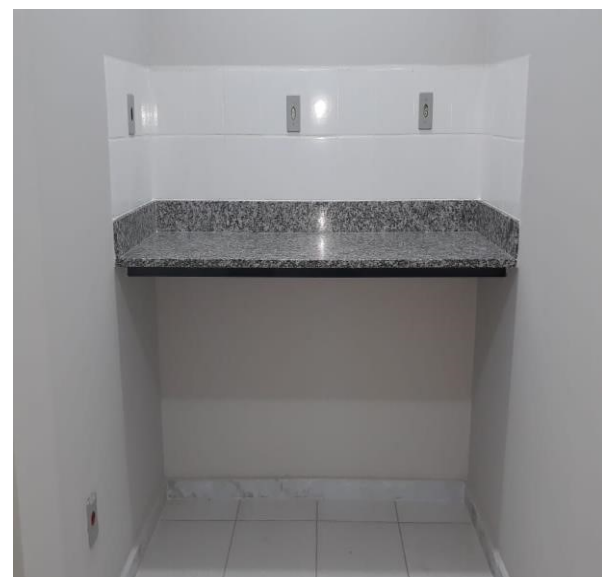
Foto 43 - HOSPITAL PÚBLICO VETERINÁRIO ÁREA DE REVELAÇÃO/SALA DE RAIOS
