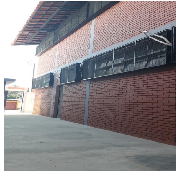
Foto 30 - HOSPITAL PÚBLICO VETERINÁRIO FACHADA INTERNA RUA PEDRO BIZZOTO- DEPOIS
