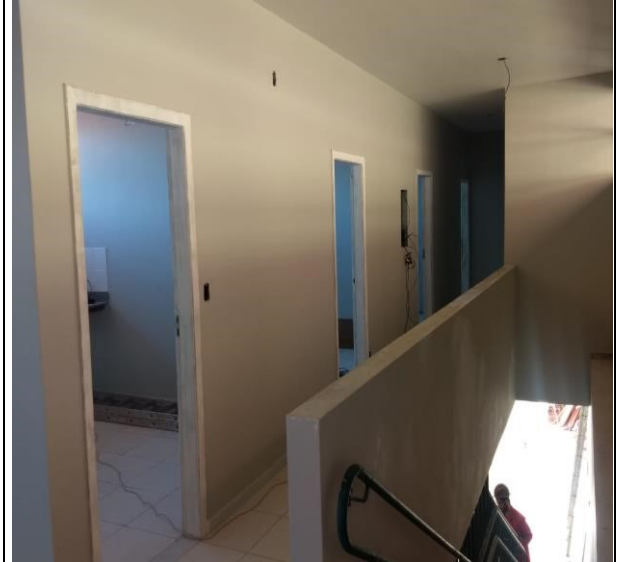
Foto 14 - HOSPITAL PÚBLICO VETERINÁRIO CORREDOR CONSULTÓRIOS - DEPOIS
