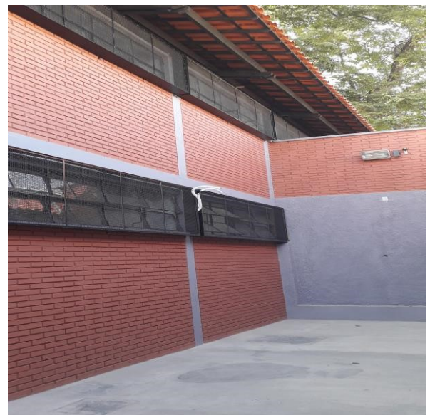
Foto 24 - HOSPITAL PÚBLICO VETERINÁRIO ÁREA DO SOLÁRIO- DEPOIS
