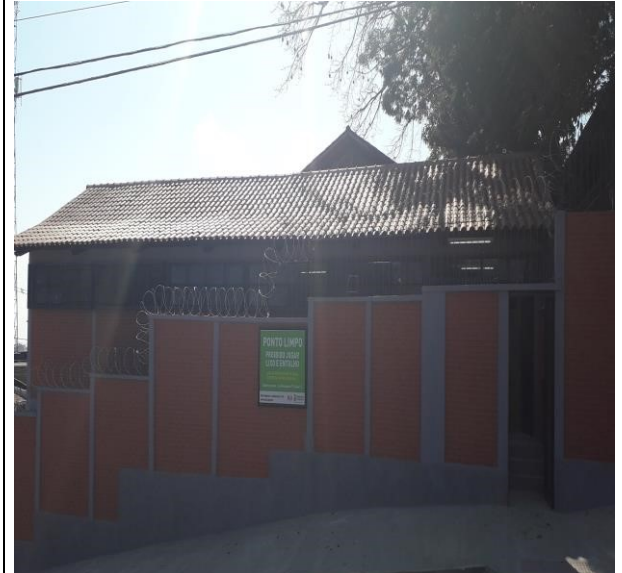
Foto 4 - HOSPITAL PÚBLICO VETERINÁRIO TELHADO FACHADA RUA PEDRO BIZZOTO - DEPOIS
