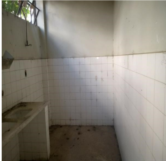
Foto 9 - HOSPITAL PÚBLICO VETERINÁRIO SALA DE INTERNAÇÃO CÃES- ANTES
