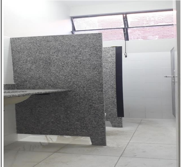
Foto 42 - HOSPITAL PÚBLICO VETERINÁRIO VESTIÁRIO FEMININO - DEPOIS
