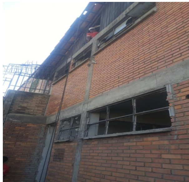
Foto 29 - HOSPITAL PÚBLICO VETERINÁRIO FACHADA INTERNA RUA ALBERT SCHARLE- ANTES
