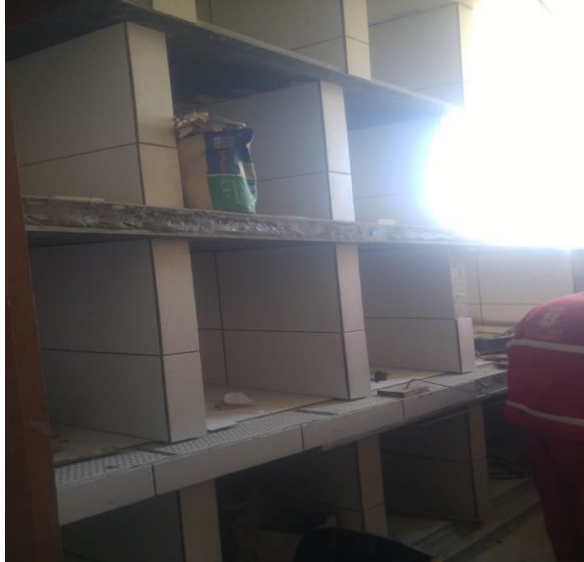
Foto 25 - HOSPITAL PÚBLICO VETERINÁRIO SALA DE INTERNAÇÃO GATOS – EM EXECUÇÃO
