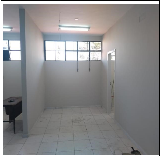
Foto 16 - HOSPITAL PÚBLICO VETERINÁRIO SALA DE ESPERA GATOS- DEPOIS
