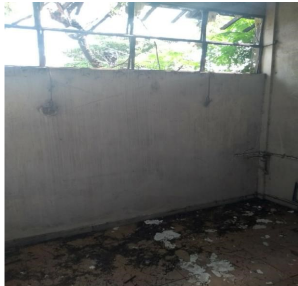
Foto 45 - HOSPITAL PUBLICO VETERINARIO ÁREA DA SALA DE ULTRASSOM - ANTES
