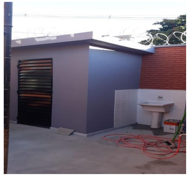
Foto 22 - HOSPITAL PÚBLICO VETERINÁRIO DEPÓSITO DE LIXO - DEPOIS
