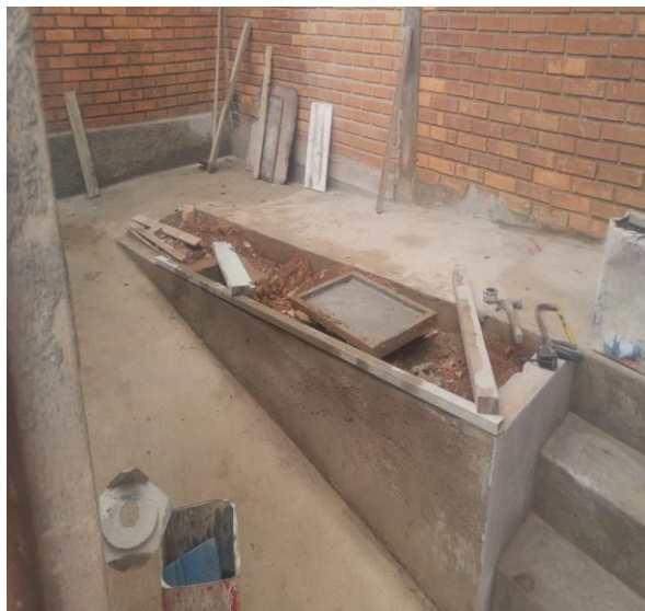
Foto 31 - HOSPITAL PÚBLICO VETERINÁRIO RAMPA DE ACESSO A UNIDADE- EM EXECUÇÃO
