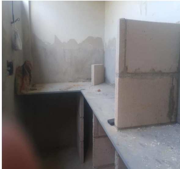
Foto 17 - HOSPITAL PÚBLICO VETERINÁRIO SALA DE INTERNAÇÃO CÃES- ANTES
