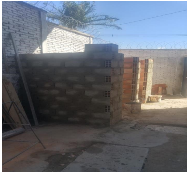
Foto 21 - HOSPITAL PÚBLICO VETERINÁRIO DEPÓSITO DE LIXO- EM EXECUÇÃO
