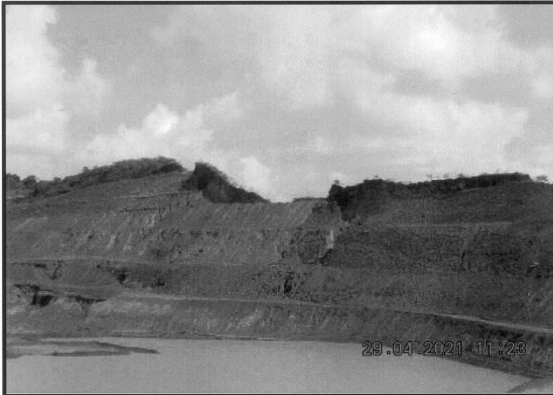
DETALHE DA FALHA.
