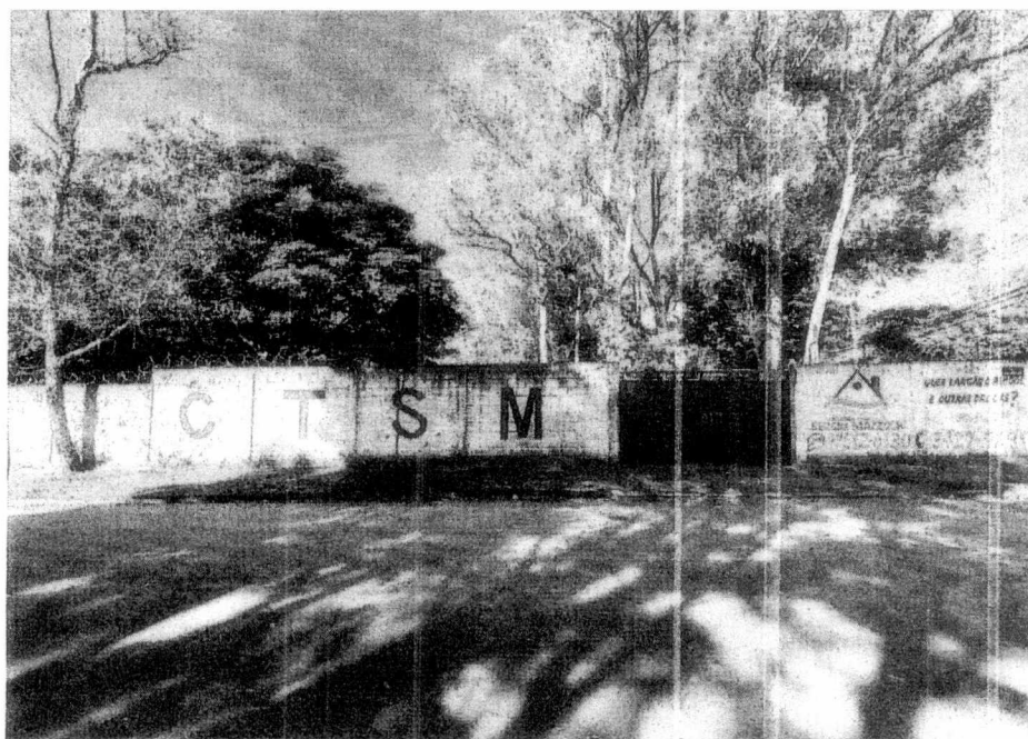
4.2. Vista lateral do imóvel – data da fiscalização (21/01/2022)
