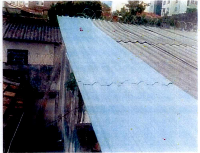
Figura 09 – Instalação e fixação de novas telhas. (Fonte: autor,25-02- 2022).
