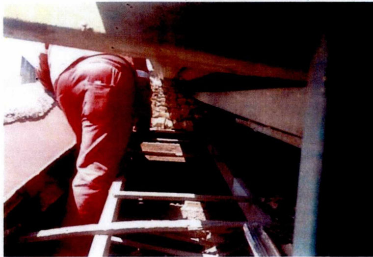
Figura 01 – Substituição de telhas danificadas e manutenção dos perfis usados para suporte e fixação das telhas. (Fonte: autor, 23-02-2022).
