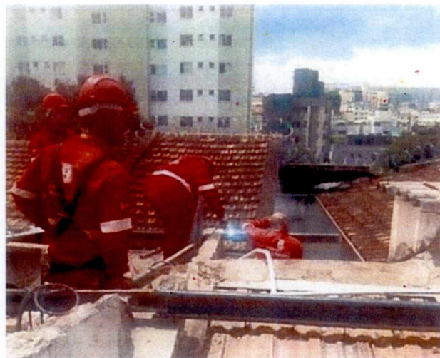
Figura 05 – Prolongamento dos perfis metálicos que servem de suporte e fixação das telhas. (Fonte: autor,24-02- 2022).
