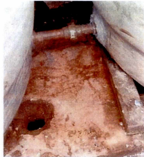
Figura 09 – Manutenção das conexões da caixa d'água sobre a sala de curativos. (Fonte: autor, 12-02-2022).
