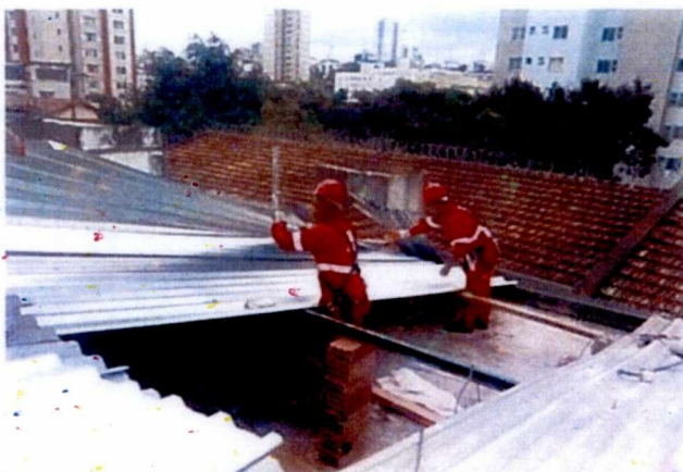
Figura 10 – Instalação de novos perfis metálicos e fixação das telhas novas. (Fonte: autor, 25-02-2022).
