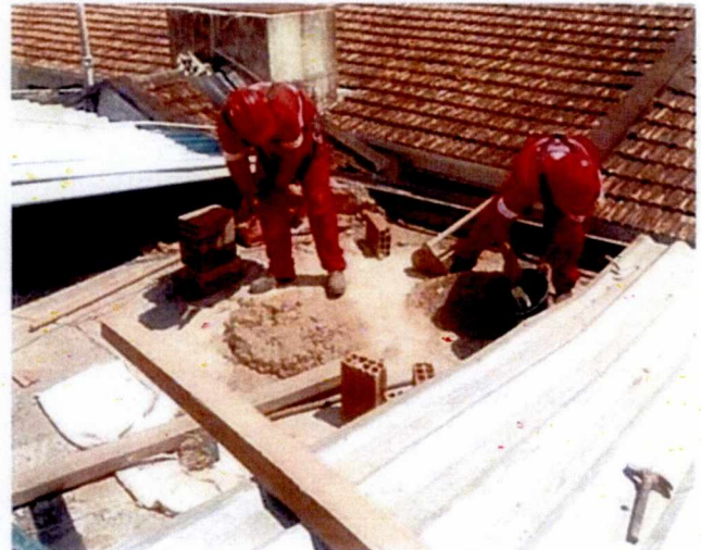
Figura 09 – Preparação de base para novos perfis de fixação das telhas. (Fonte: autor, 24-02- 2022).
