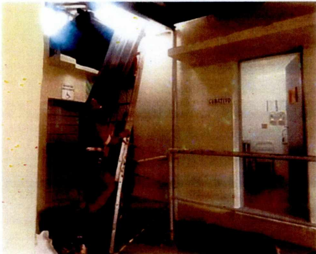
Figura 08 – Substituição das telhas. (Fonte: autor, 11-02- 2022).
