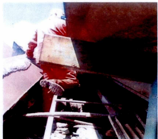
Figura 03 – Remoção de telhas danificadas e manutenção dos perfis usados para suporte e fixação das telhas. (Fonte: autor, 23-02-2022).
