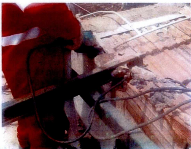
Figura 06 – Prolongamento dos perfis metálicos que servem de suporte e fixação das telhas. (Fonte: autor,24-02- 2022).
