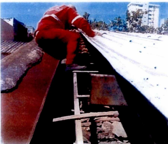
Figura 02 – Remoção de telhas danificadas e manutenção dos perfis usados para suporte e fixação das telhas. (Fonte: autor, 23-02-2022).
