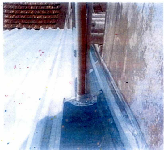
Figura 11 – Instalação de novo rufo e de manta para vedação do telhado. (Fonte: autor, 25-02-2022).
