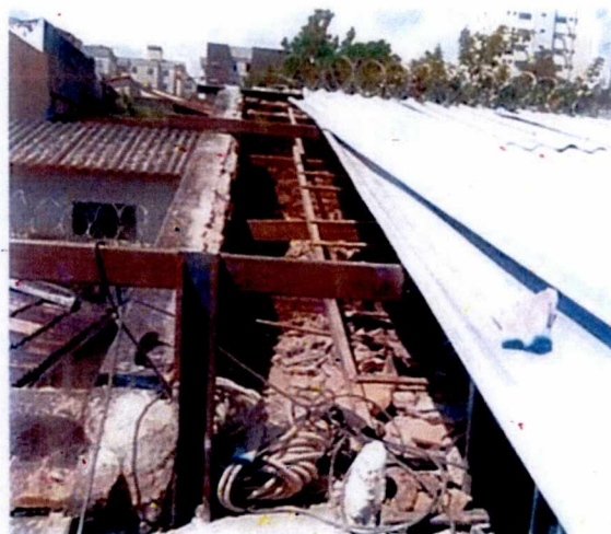
Figura 07 - Prolongamento dos perfis metálicos que servem de suporte e fixação das telhas. (Fonte: autor,25-02- 2022).
