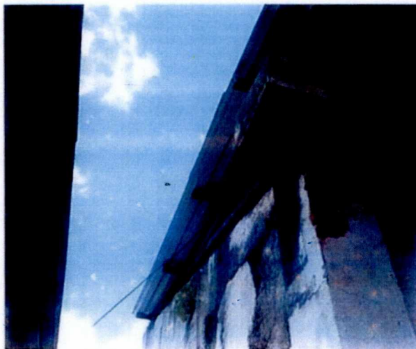
Figura 10 – Telha instalada sobre suportes prolongados. (Fonte: autor, 25-02-2022).
