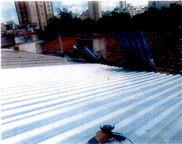
Figura 08 – Instalação e fixação de novas telhas. (Fonte: autor,25-02- 2022).
