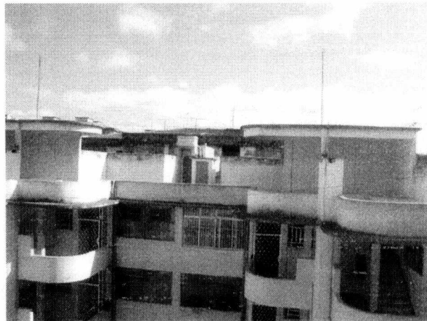
Ainda no Ed. 2, a circulação, mostrando a saída para o Edifício 4.
