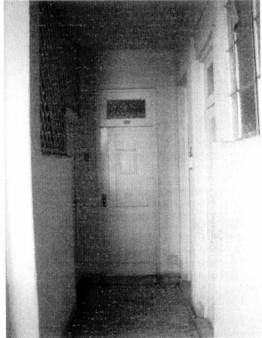
Entrada comum a dois apartamentos, no edifício 10. A porta em frente é original, exceto na cor. As cancelas foram substituídas por portas. O fechamento da área de serviço ainda é de treliça de madeira.
