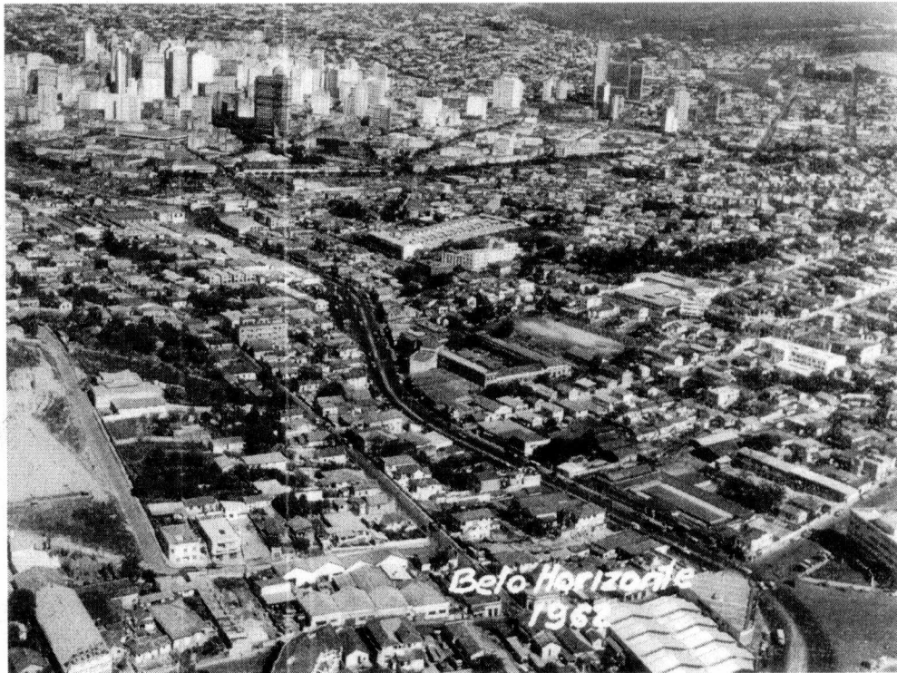
Vista geral do entorno do Conjunto, mostrando o Bairro Lagoinha e Av. Antônio Carlos.
