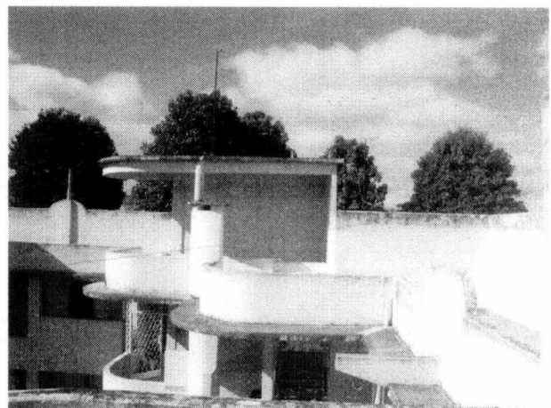
Do lado oposto, detalhe da chegada às escadas. No fundo o topo das árvores no jardim de frente para a Av. Antônio Carlos.
