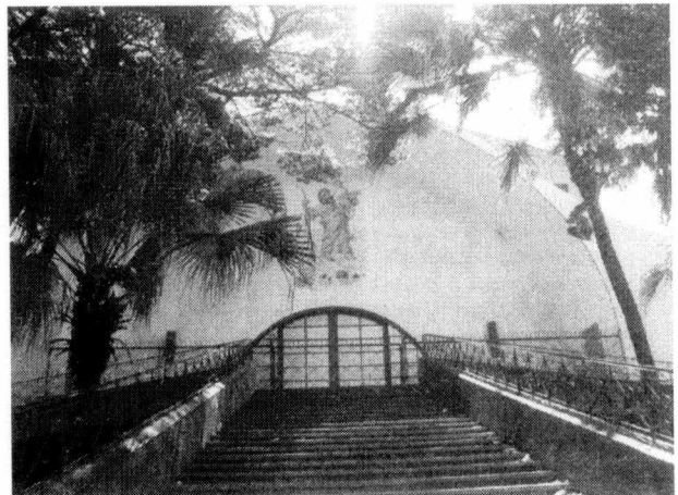
Escadarias de acesso frontal à nave.
