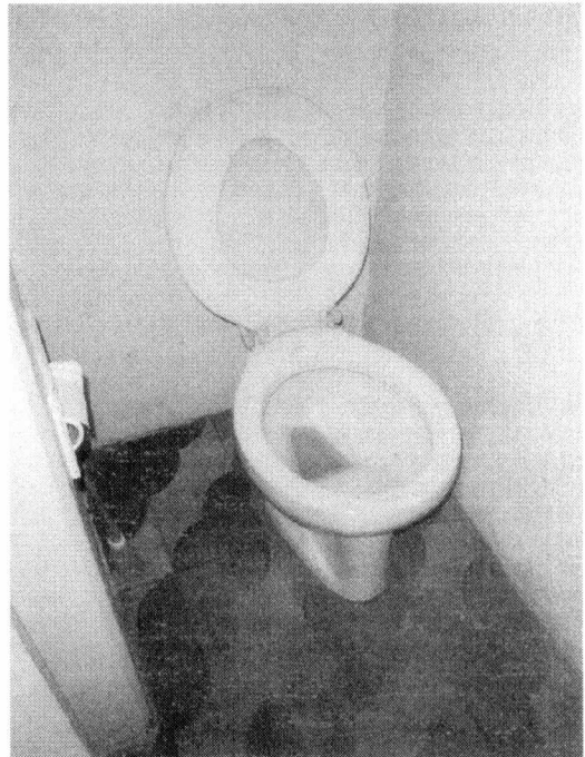
Instalação sanitária, no piso original.
