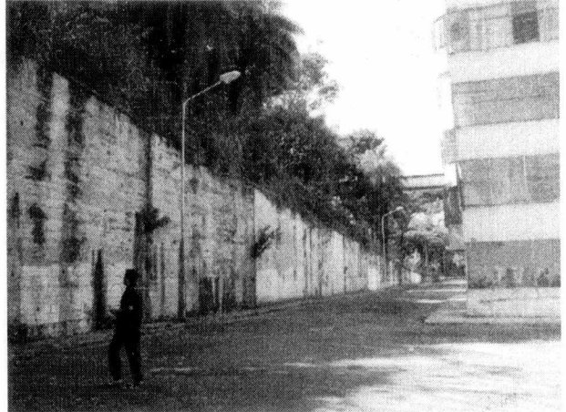
O muro de arrimo, vendo-se ao fundo a passarela que liga o Edifício 10 à Rua Araribá.
