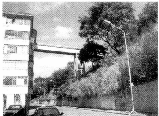
Vista da passarela que liga o Edifício 5 à Av. José Bonifácio.
