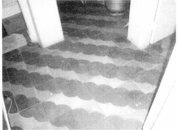
Detalhe do ladrilho hidráulico que compõe a cozinha e banheiro. As portas e janelas eram originalmente pintadas com a cor avermelhada deste piso
