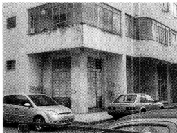
Vista das lojas no 1º pavimento do Edifício 7.
