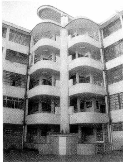
Do mesmo edifício, a Ala B, contígua. Cada ala possui 4 apartamentos por andar, uma circulação vertical independente e um duto coletor de lixo.
