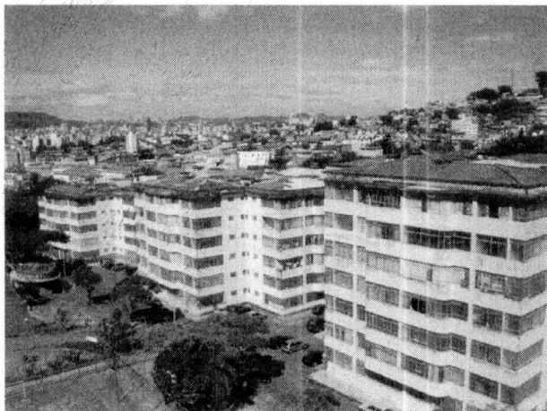
Vista dos Edifícios 3, 5 e 7, tomada do último andar do Edifício 10. No fundo a Serra do Curral e Rola-Moça.
