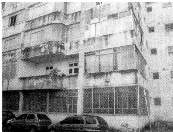
Aproximação, com enfoque para a varanda ainda aberta, no apartamento 213 do Edifício 2.
