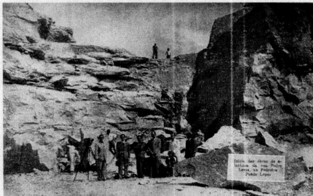
Início das obras de abertura da Rua Pedro Lessa na pedreira Prado Lopes. Fonte: Relatório dos Exercícios de 1940 e 1942.
