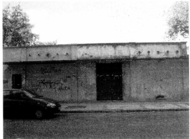
Fachada da antiga casa de força, em frente ao Edifício 10. Neste local funcionavam os transformadores. É a única que tem planta retangular. Atualmente serve de apoio para a SLU.
