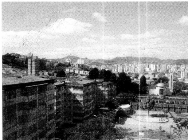
Vista parcial, Edifícios 2, 4 e 6 e fundos da Escola Honorina de Barros e Igreja de São Cristóvão. Ao fundo a Serra do Curral.
