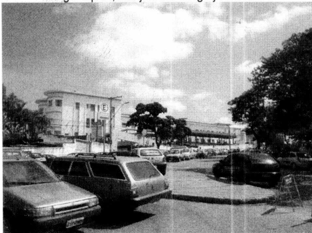
Vista do início da Av. José Bonifácio, tendo ao fundo o Hospital Odilon Behrens.
