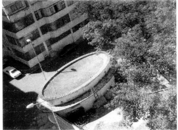
Vista da "casa de força" onde funciona a Associação de Moradores.
