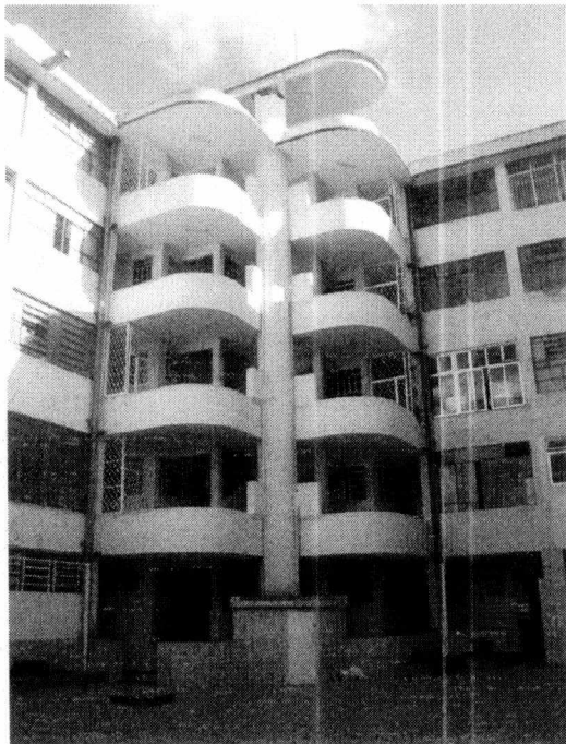
Vista interna do Edifício 2, Ala C, do pátio interno. As áreas arredondadas são as circulações horizontais.
