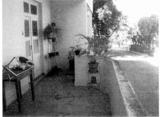
Outra vista da varanda. Este tipo de varanda está presente nos apartamentos de final 01, 04, 05, 08, 09, 12, 13 e 16, exceto no 1º pavimento .
