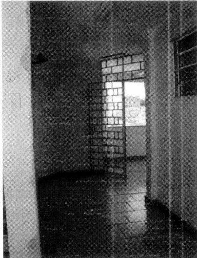
No Edifício 8, 6º andar, o acesso para a passarela.
