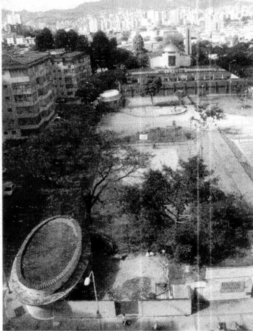
Vista parcial focalizando, mais a direita, uma "casa de força", de planta elíptica, onde funciona atualmente a sede da Associação de Moradores. Ao fundo, em frente ao Ed. 4, outra "casa de força" de planta elíptica.
