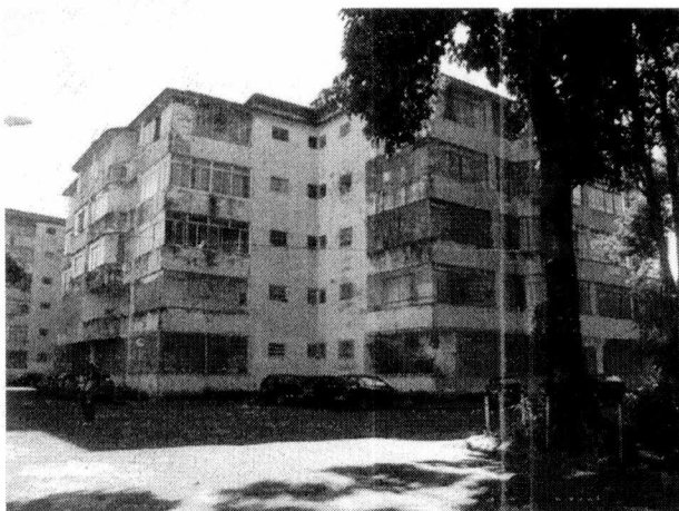
Vista externa, tomada em frente à casa paroquial, do Edifício 2.
