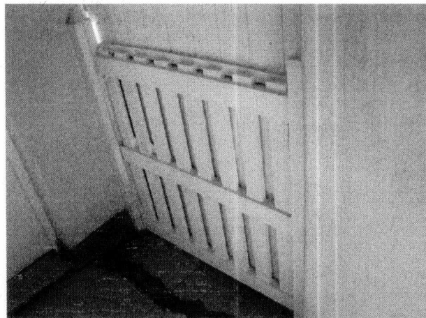
Detalhe da cancela original, em réguas de madeira, altura aproximada de 1 metro, para acesso a área de serviço do apartamento 213 do Edifício 2, vedado posteriormente pelo morador.
