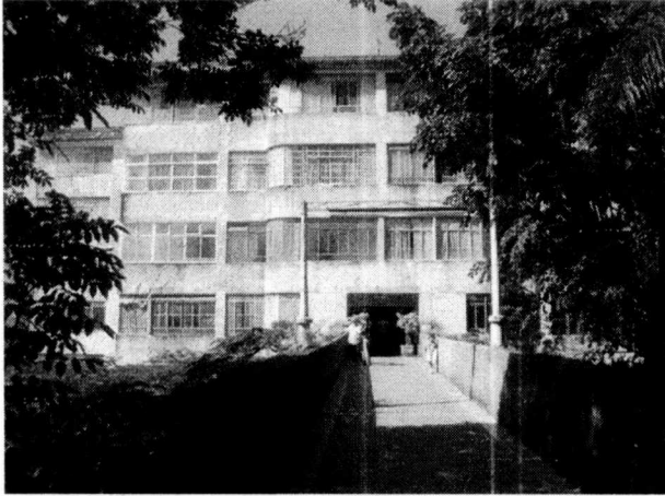
Vista da passarela de acesso ao Edifício 10, tomada da entrada da Rua Araribá.
