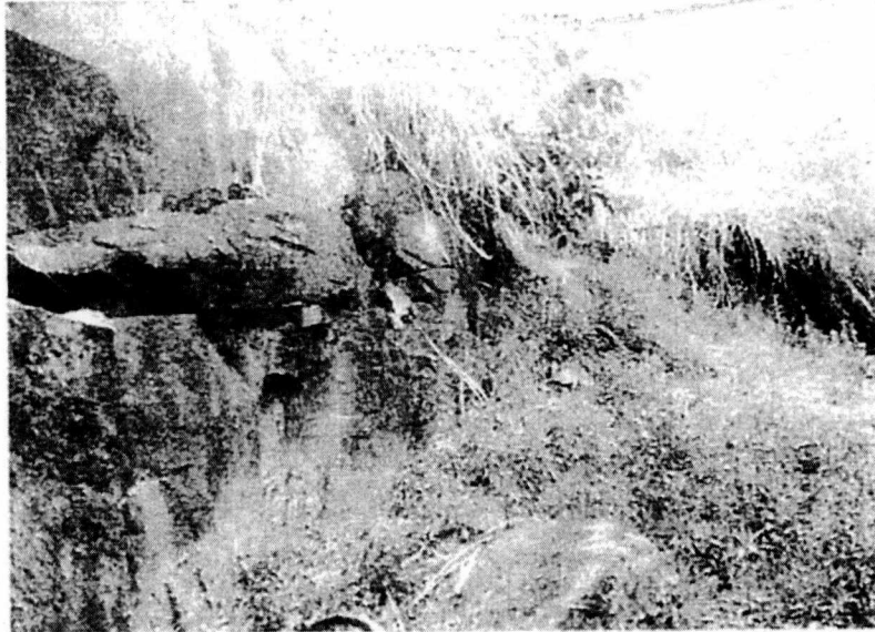
Talude lateral. Catação dos chocos e desmonte ou tela de contenção.
