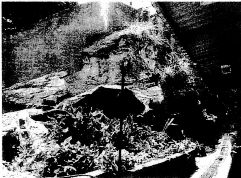
Ancoragem com contrafortes (caso extremo e mais dispendioso) ou revestimento com concreto para impedir a erosão do bloco e na base (também estabiliza).
